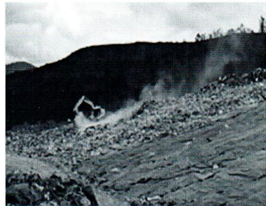
Fotografía 4. Aplicación de cal sobre residuos – Frente de disposición
