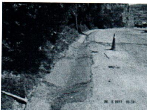
Reconstrucción de Cuneta en Concreto Fuente: INTER DJ
