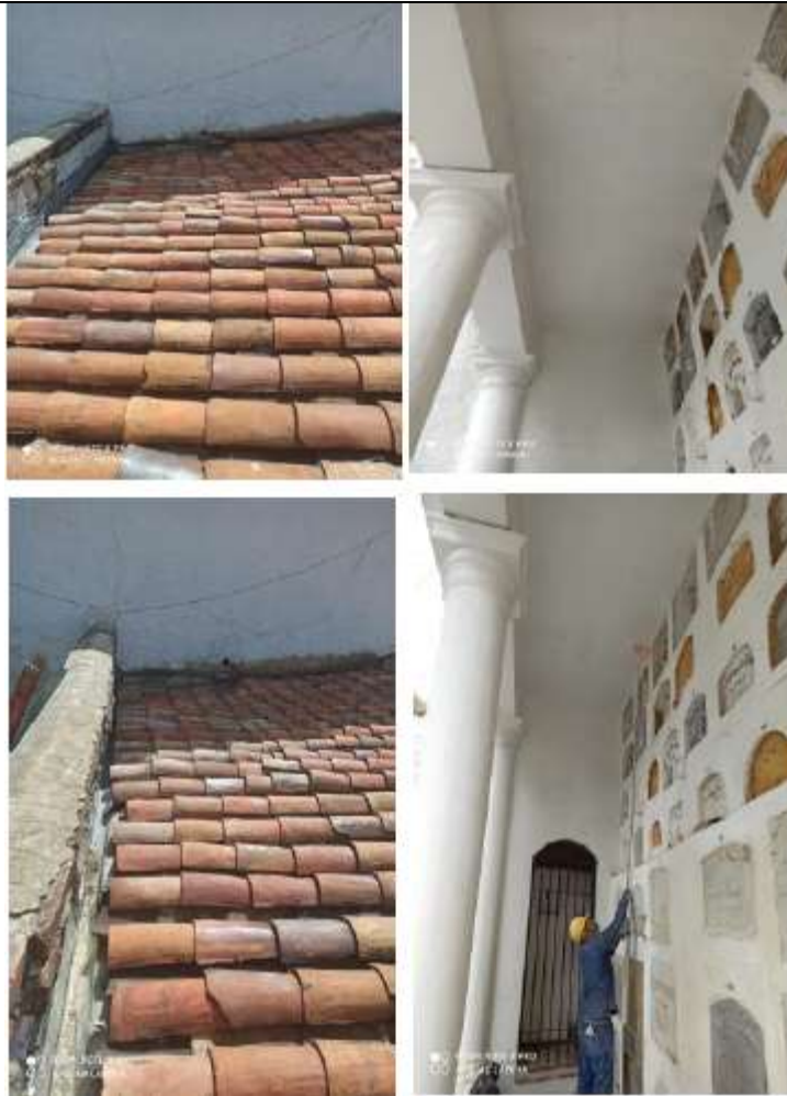
Imagen 7: Cementerio Central – Mantenimiento cubierta histórico costado Nor oriental
