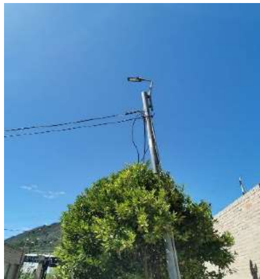
Imagen 5: Cementerio Parque Serafín – Arreglo y reinstalación de poste de iluminación de poste de acceso.
