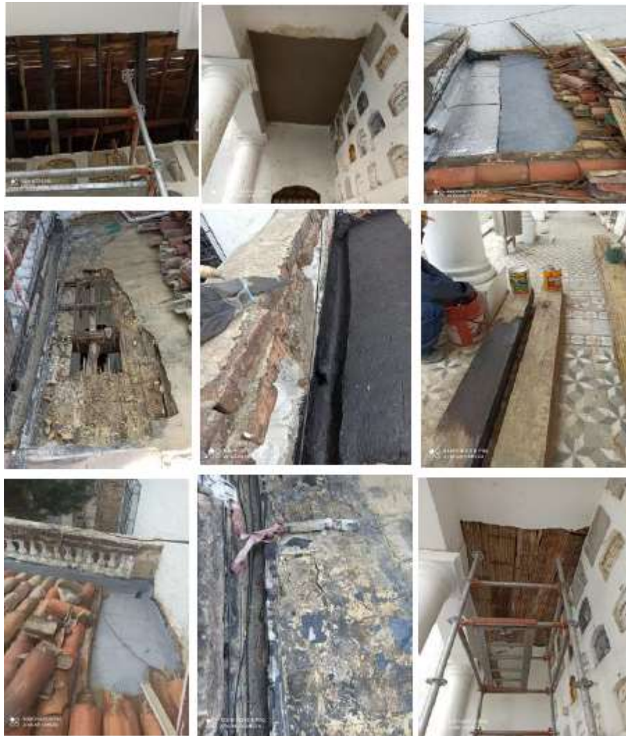
Imagen 6: Cementerio Central – Mantenimiento cubierta histórico costado Nor oriental.
