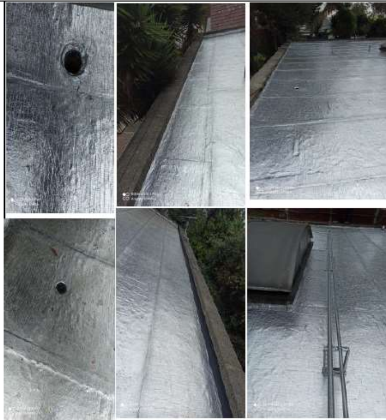
Imagen 1: Cementerio Norte - Mantenimiento impermeabilización cubierta administración
