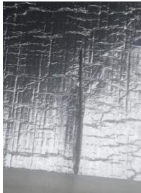
Mantenimiento impermeabilización sur por daño- Cementerio Sur
