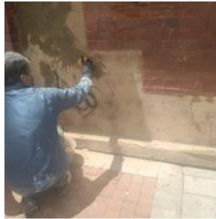
Mantenimiento fachado cll 26
