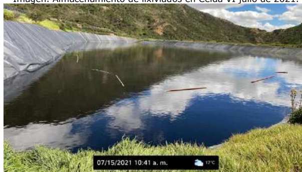
Imagen. Almacenamiento de lixiviados en Celda VI julio de 2021.
