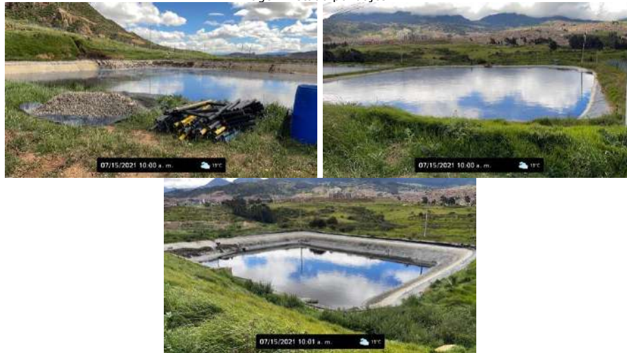
Imagen. Estado pondajes II.
