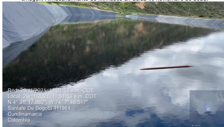
Imagen. Almacenamiento de lixiviados en Celda VI noviembre de 2021.
