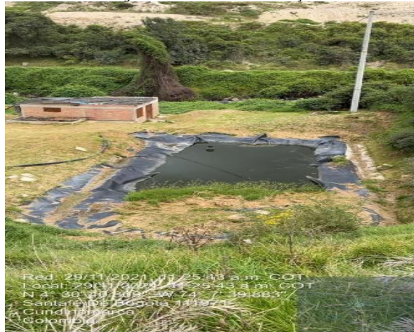
Imagen. Estado Actual de Pondaje IV
