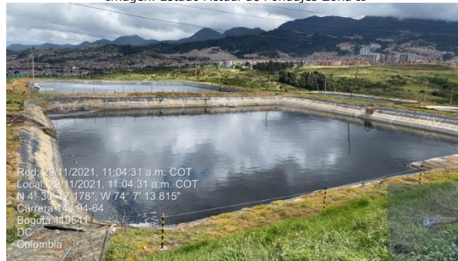
Imagen. Estado Actual de Pondajes Zona II
