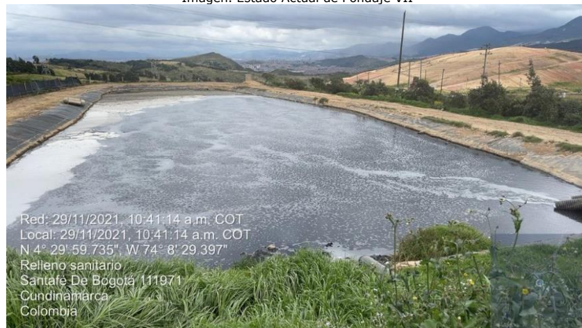
Imagen. Estado Actual de Pondaje VII
