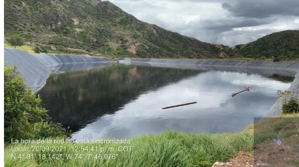
Imagen. Almacenamiento de lixiviados en Celda VI septiembre de 2021.
