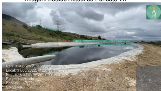
Imagen. Estado Actual de Pondaje VII
