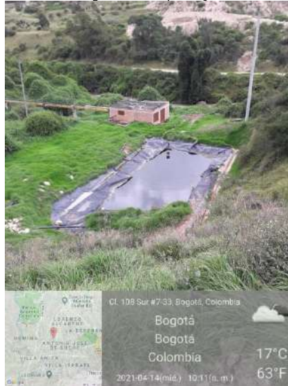
Imagen. Estado pondaje IV
