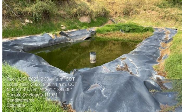
Imagen. Estado Actual de Pondaje IV
