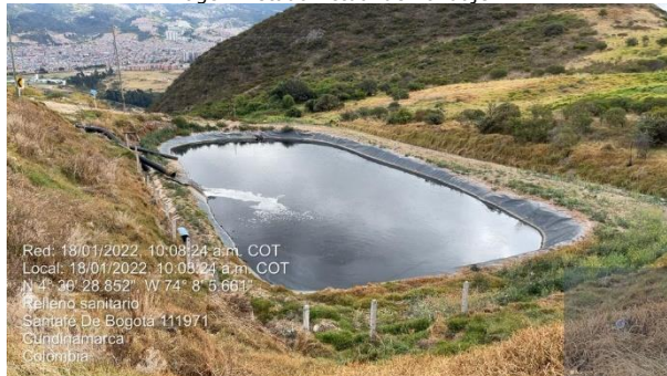
Imagen. Estado Actual de Pondaje VII
