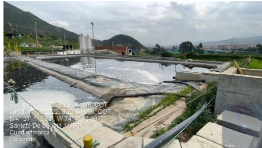
Imagen. Estado Actual de Pondajes PTL
