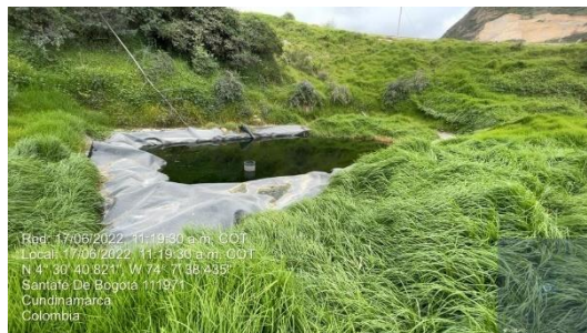
Imagen. Estado Actual de Pondaje IV
