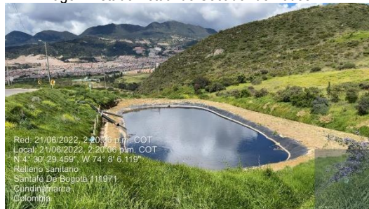
Imagen. Estado Actual de Secador de Lodos
