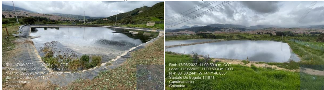
Imagen. Estado Actual de Pondajes II
