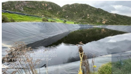
Imagen. Estado Actual de Celda VI
