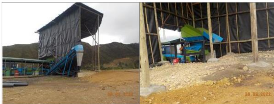
Fuente: Interventoría. Adecuación de infraestructura en el Polígono de Interés.
