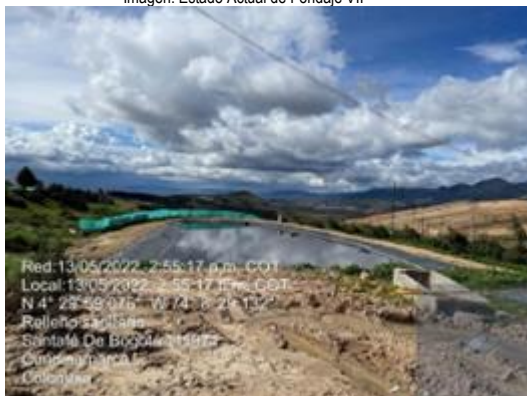
Imagen. Estado Actual de Pondaje VII
