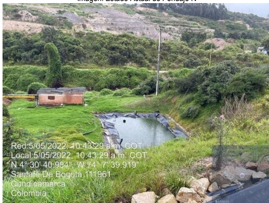
Imagen. Estado Actual de Pondaje IV
