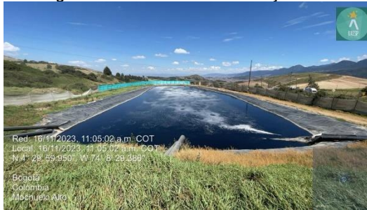
Imagen. Estado Actual de Pondaje VII
