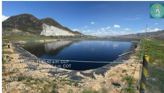
Imagen. Estado Actual de Pondajes II
