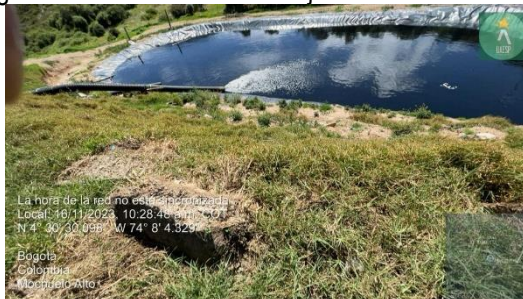
Imagen. Estado Actual de Pondaje Secador de Lodos
