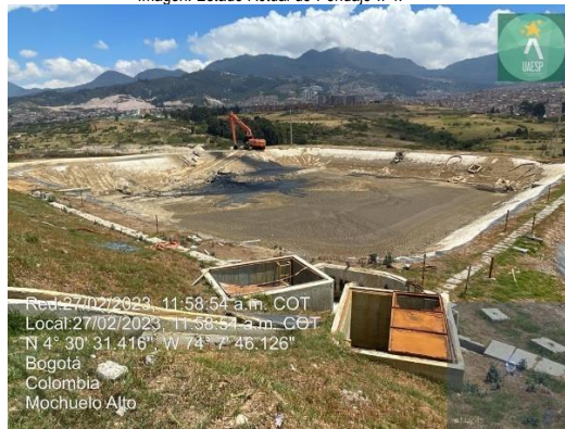
Imagen. Estado Actual de Pondaje II-4.
