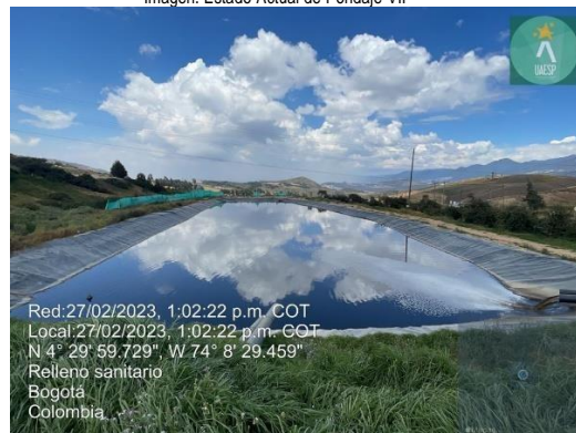
Imagen. Estado Actual de Pondaje VII
