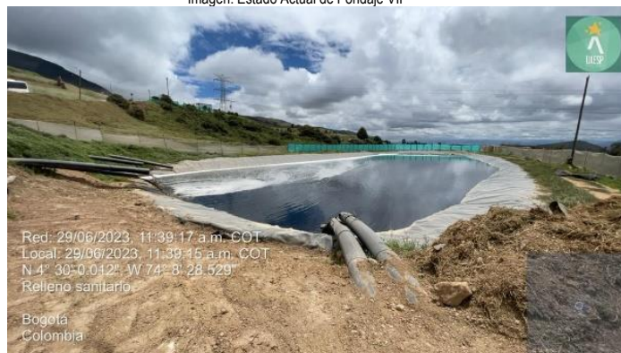
Imagen. Estado Actual de Pondaje VII
