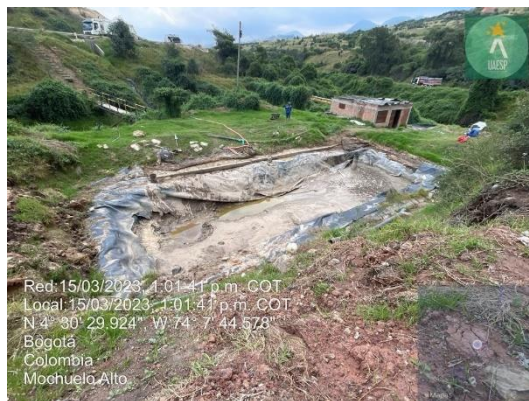
Imagen. Estado Actual de Pondaje IV
