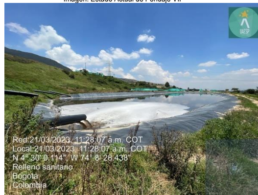
Imagen. Estado Actual de Pondaje VII
