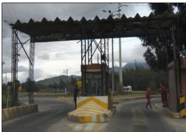
Fotografía 2-1. Ingreso vehicular del Relleno Sanitario Doña Juana
