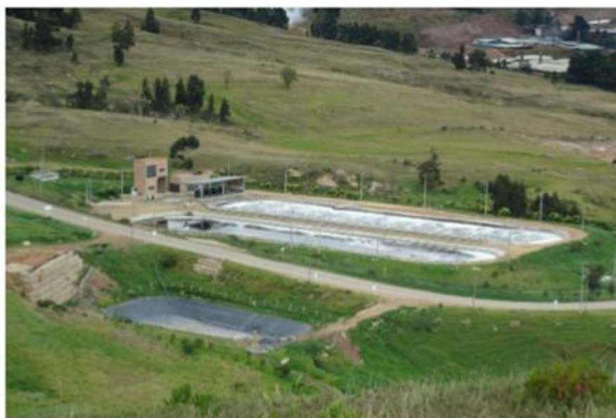
Fotografía 2-6. Sistema Batch Reactor - SBR Pondajes
