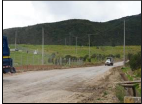
Vía en afirmado a zonas rellenas
