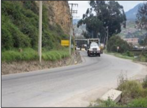
Vía pavimentada del acceso principal
