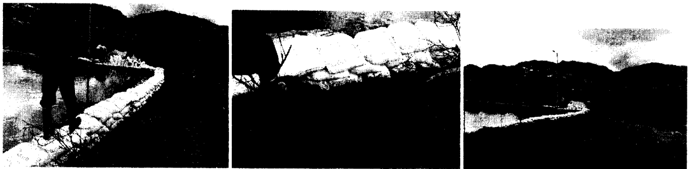
Desbordamiento del pondaje II antiguo, fecha 20/05/2014.
