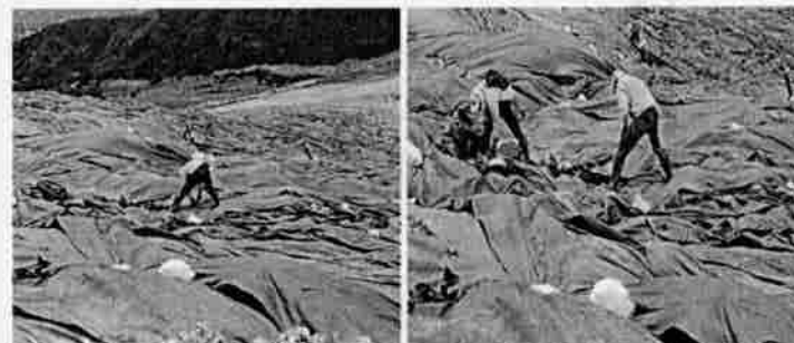
Figura: 3. Retapado y cocido de polietileno. Fuente: UAESP Octubre 2014.
