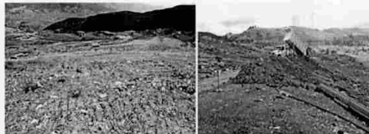
Figura: 1. Reemplazo de cobertura de polietileno por arcilla Fuente: UAESP Octubre 2014
