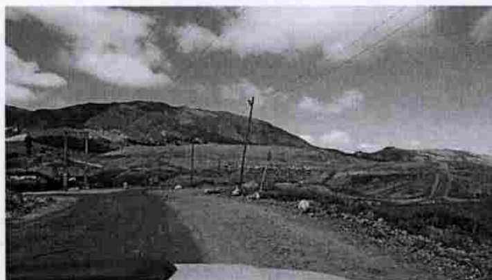
Reemplazo en cobertura de polietileno por arcilla en Optimización Fase 1 Fuente: UAESP Diciembre 2014
