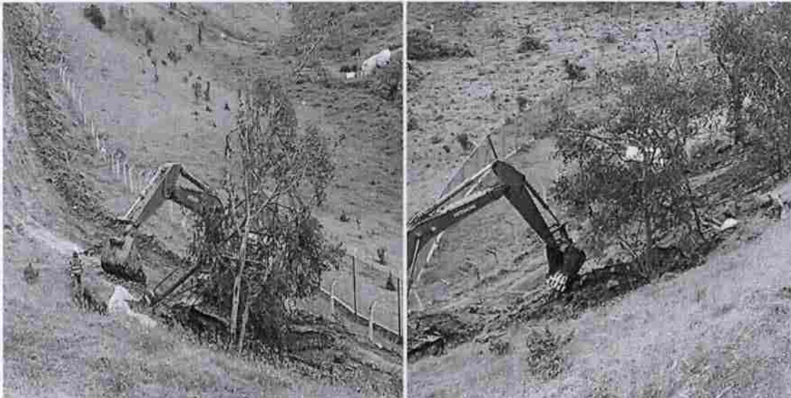
Trasplante de árbol, sin retiro del amarre radicular Fuente: UAESP 01 de diciembre de 2014. Fase 2
