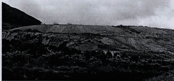
Figura: 1. Reemplazo de cobertura de polietileno por arcilla
