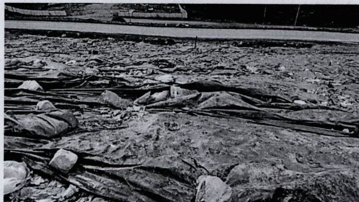
Figura: 3. Cobertura de polietileno talud occidental Zona VII
