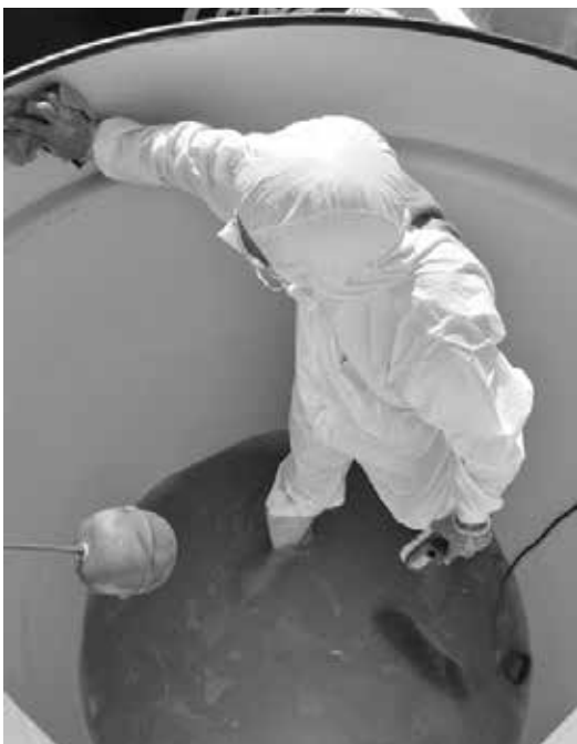
Demostración de limpieza de tanque. Fuente: Copalgroup
