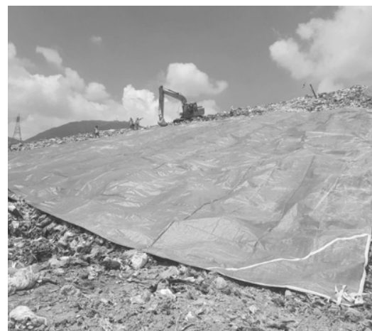
Cobertura temporal mantos y geomembrana.
