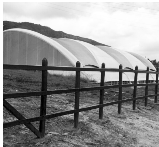
Cerramiento, en material de plástico reciclado, para proteger el centro multipropósito.
