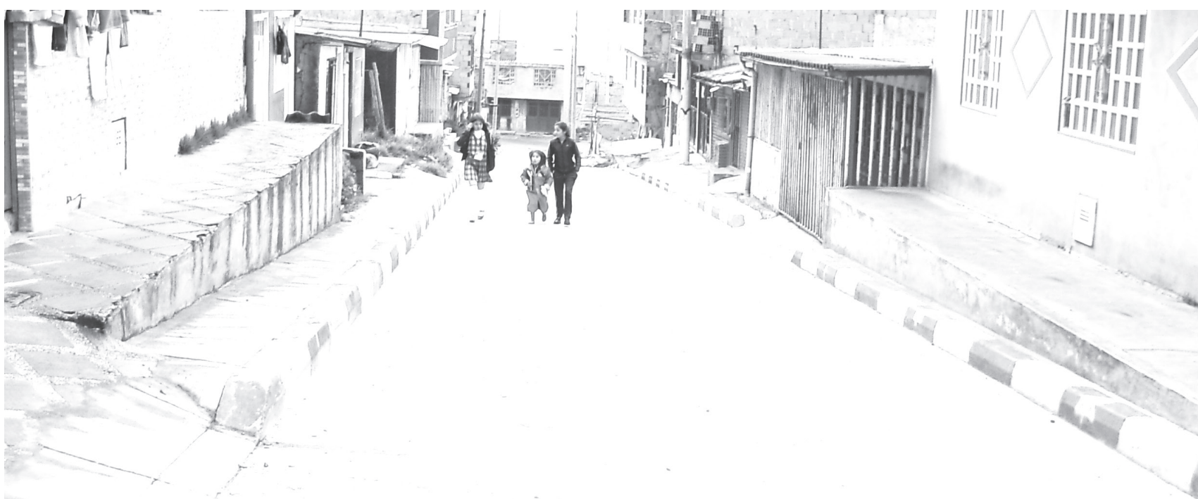
Vía terminada por gestión.
