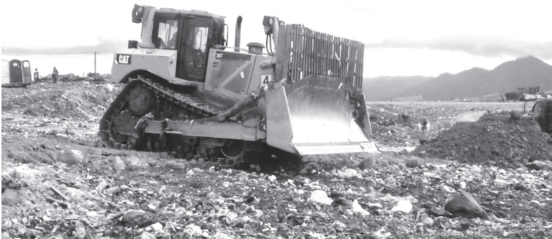
Buldócer en actividad zona de disposición final Relleno Sanitario Doña Juana.
