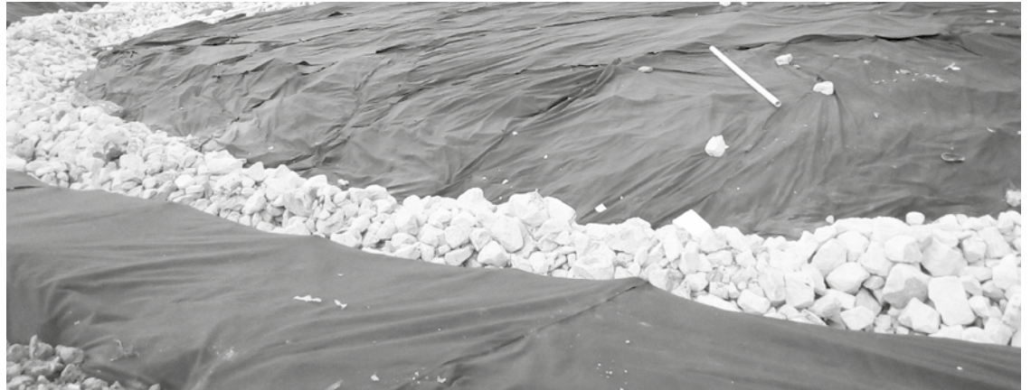
Avance en la adecuación de costado norte.
