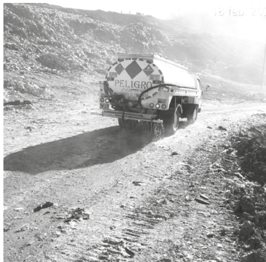
Humectación de vías.
