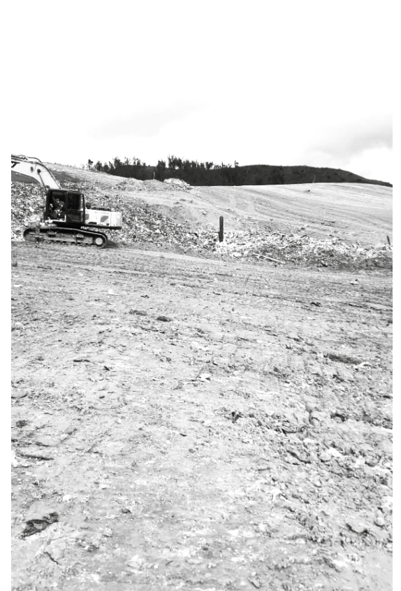
Coberturas con arcilla costado sur Zona VII Fase II.
