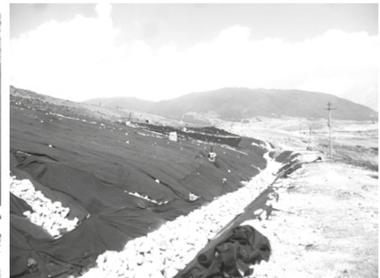
Llave de anclaje con filtro para el drenaje de lixiviados.
