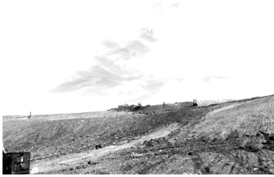
Cobertura total en arcilla.
