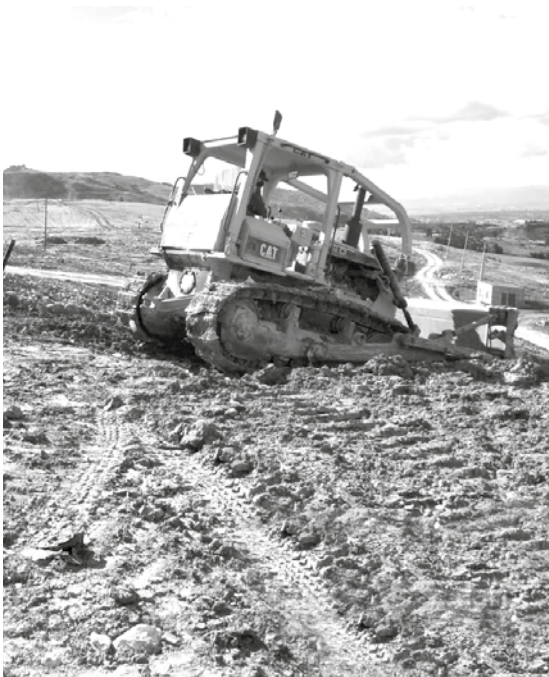
Cobertura total en arcilla.
