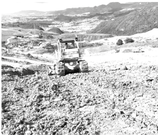
Cobertura total en arcilla.
