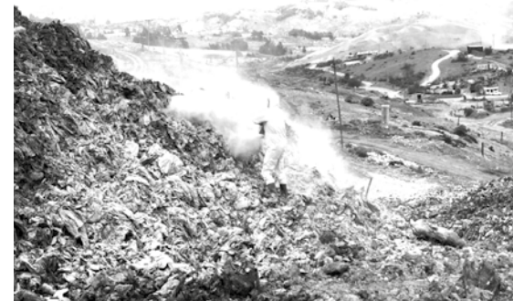
Control olores, aplicación de cal en la zona del evento.
