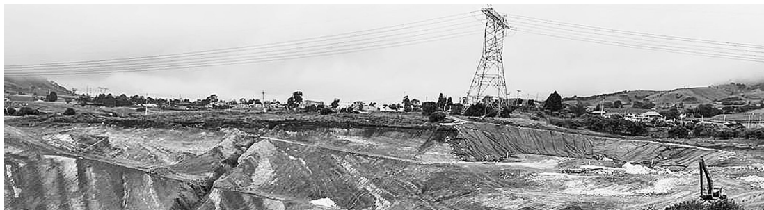
» Adecuaciones terraza 4B.
