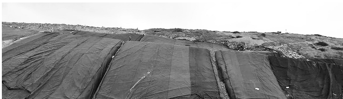
» Adecuaciones terraza 4B.
