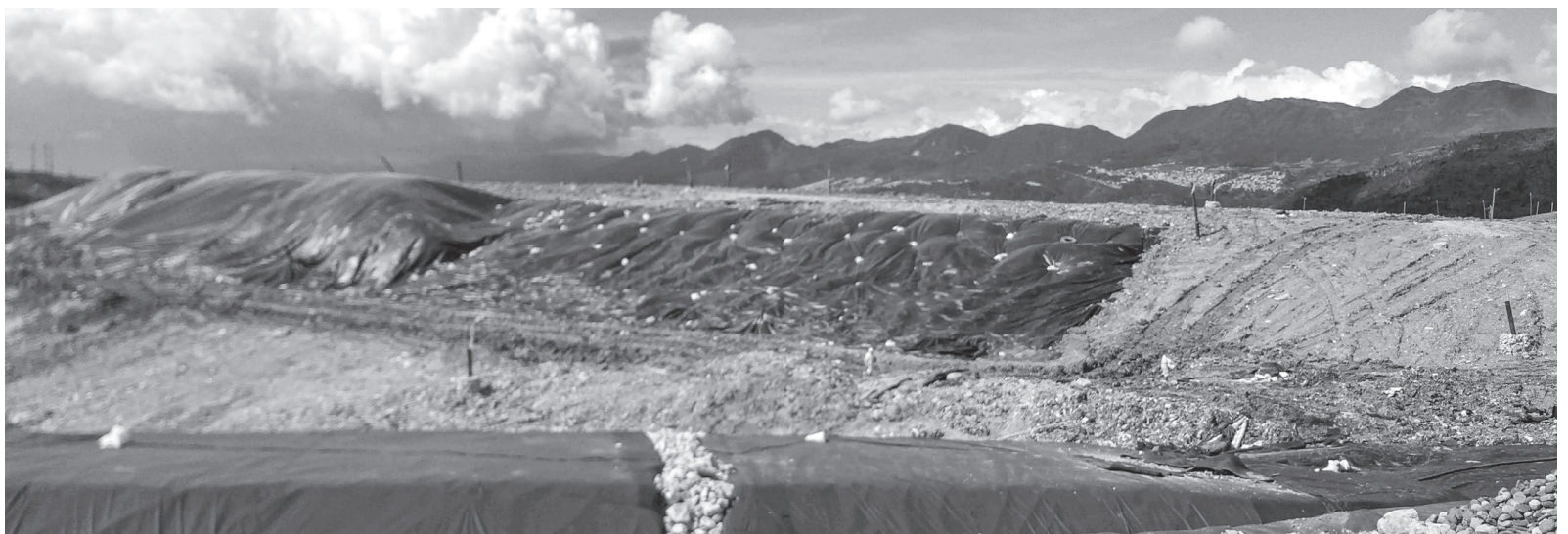
» Geomembrana con termosellado, la cual se instala de forma hermética para disminuir la presencia de oxígeno y luz solar necesarios para el desarrollo de las moscas, así como reducir el espacio disponible para el ingreso o salida de moscas desde los residuos al ambiente.
