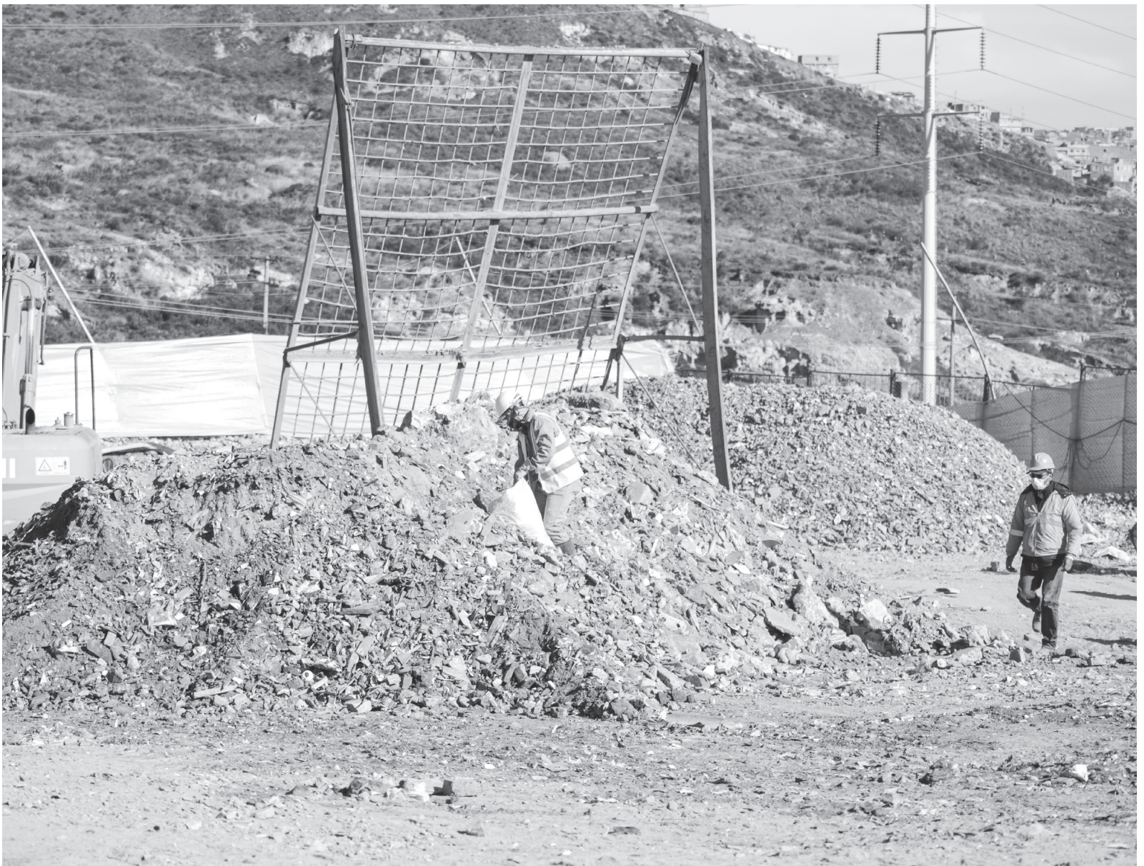
» En el Punto Limpio de la UAESP se reciben, separan, limpian y tratan los residuos de demolición y construcción.
