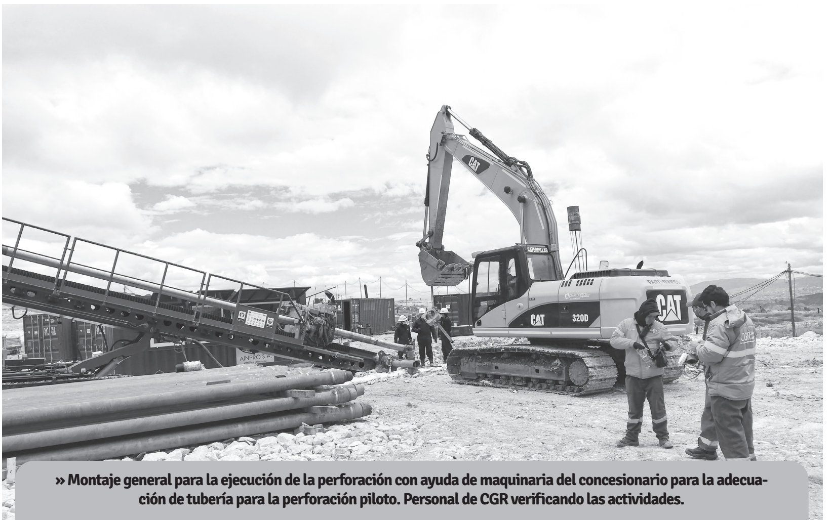
» Operador de la máquina de perforación verificando mediante ondas electromagnéticas que el trazado de la perforación se esté ejecutando según el diseño proyectado por el concesionario.
