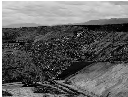
Figura 5-23: Drenaje de fondo e impermeabilización de terrazas
