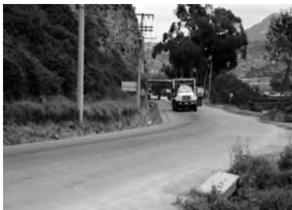
Vías de acceso pavimentadas 6
