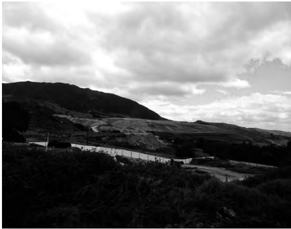
Zonas antiguas con cobertura final con y sin vegetación
