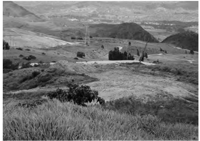
Celda de residuos hospitalarios
