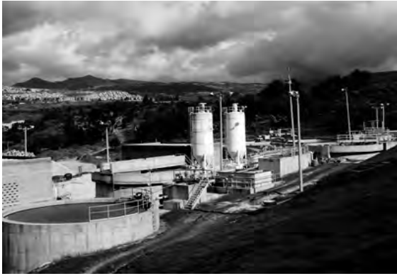
Planta de Tratamiento de Líquidos Percolados
