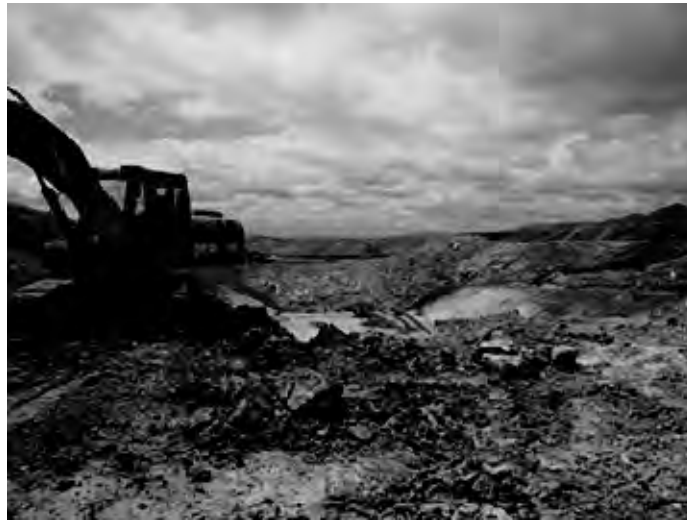
Figura 5-20: Etapa de adecuación del fondo del relleno
