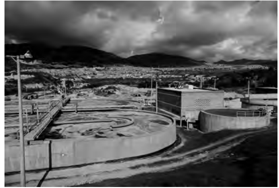
Planta de Tratamiento de Líquidos Percolados
