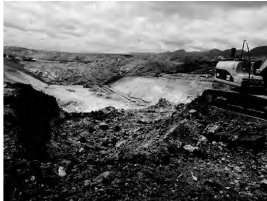
Figura 5-22: Excavación de terrazas
