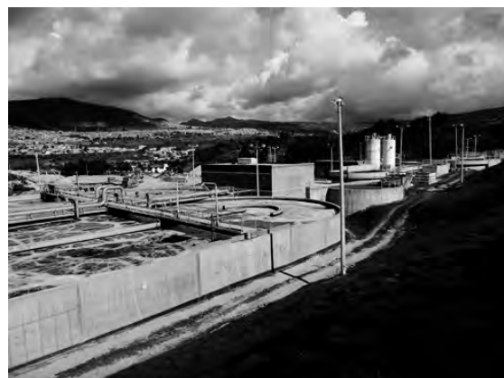
Planta de Tratamiento de Líquidos Percolados
