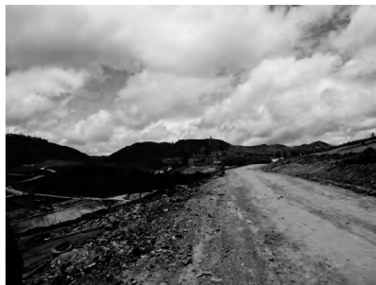
Vías acceso frente de descarga
