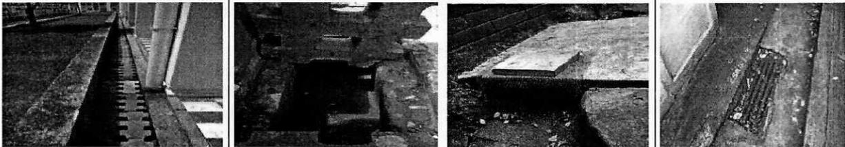
Foto No. 5 Limpieza de sumideros e instalación de malla protectora sobre la estructura Cementerio del Norte
