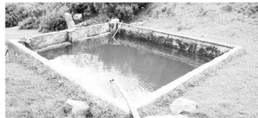
Tanque de reserva y mangueras que proporcionaban agua a la comunidad.
