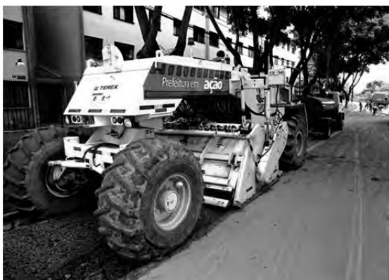
(5) Equipo “TEREX RS425C” para fresado, reciclaje e aplicación simultánea del pavimento asfáltico
