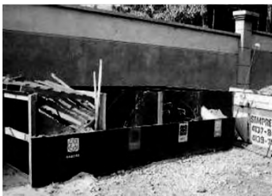
(1) Segregación de residuos en el frente de obra
