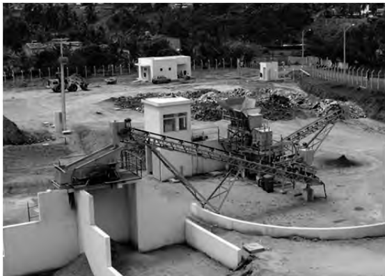
(4) Planta fija para reciclaje de escombros
