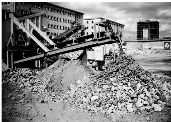
(2) Equipo móvil para reciclaje “in situ” de escombros de demolición
