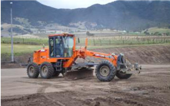
Se realizó la construcción de filtros en la cancha de fútbol, con el fin de evitar empozamientos de aguas lluvias. Los filtros fueron construidos en Geotextil y triturado y luego se procedió a nivelar y compactar el terreno con apoyo de la topografía.
