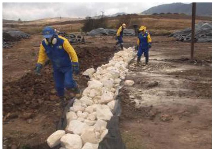
Se realizó la construcción del filtro perimetral del costado norte de la Zona VII. Adicionalmente se están construyendo los filtros sobre residuos antiguos, que tendrán como función principal transportar el lixiviado generado por los nuevos residuos al filtro perimetral y de allí a la conducción principal.
