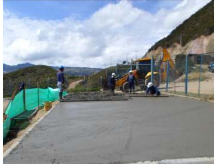
Se inició la construcción del Punto de Almacenamiento de Combustible en donde se realizaron actividades como: Construcción de la placa de contrapiso para la instalación de los tanques, instalación de tanques de almacenamiento, construcción de la placa de tanqueo, manejo de derrames e instalación del surtidor.
