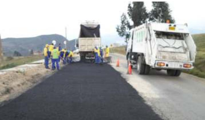
Se realizó el mantenimiento de tres tramos de la vía principal, aproximadamente 340 metros cuadrados, en donde se instaló Rajón, Subbase, Base y Asfalto. Los tramos intervenidos se ubican entre los postes 5-6, 102-103 y 112-113.
