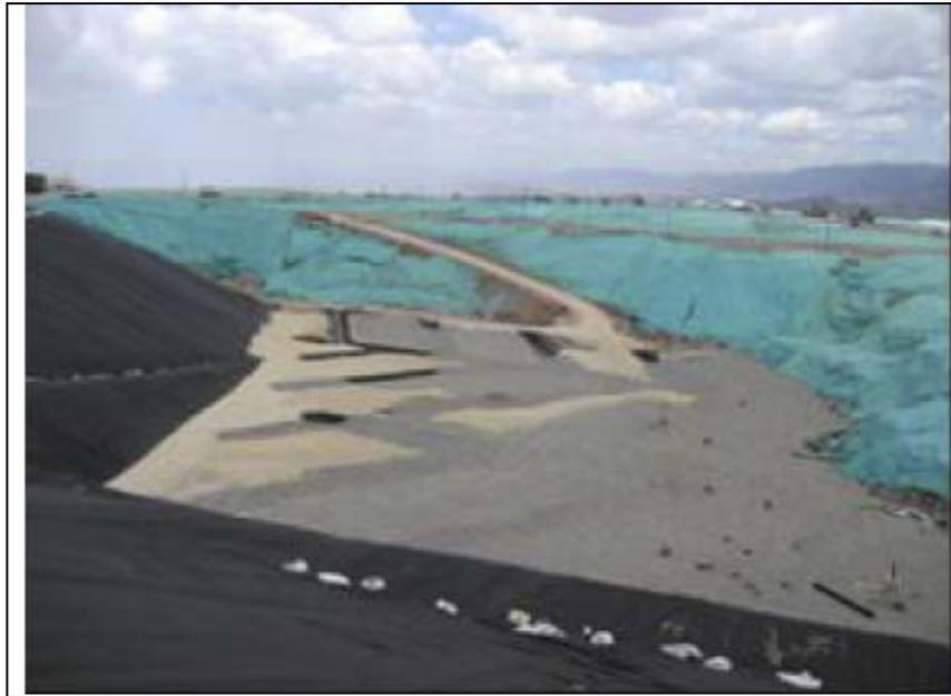
Figura 12. Pondajes de almacenamiento temporal de lixiviados
