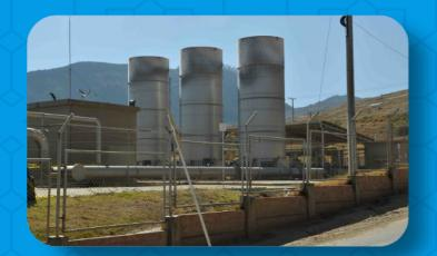
Quema del biogás captado en el RSDJ, a razón de un flujo de 5.000 y 6.000 Nm3/h, para el año 2016.
