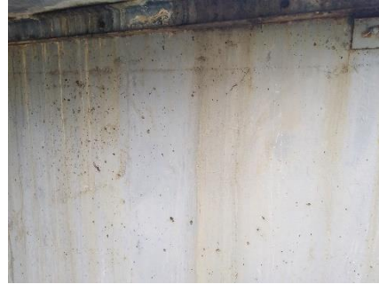
Fotografía 5. Manchas de rebose del caudal de lixiviados en la planta de tratamiento
