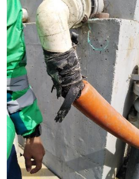
Fotografía 6. Reparaciones efectuadas por CGR
