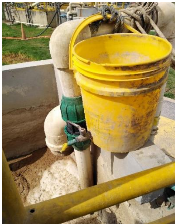
Fotografía 1. Sistema dosificador de químico utilizado por CGR
