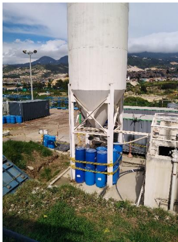
Fotografía 7. Almacenamiento de productos químicos a la intemperie
