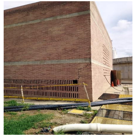
Fotografía 3. Presencia de agrietamiento en el edificio de soplantes
