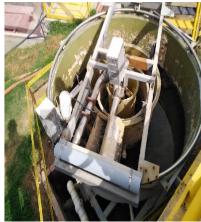
Fotografía 2. Sistema DAF averiado
