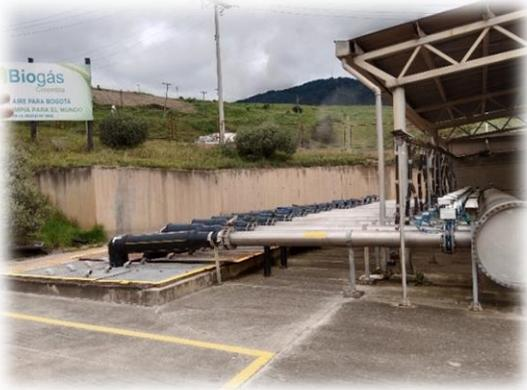
Sistema de conducción del Biogás. En esta parte se lleva a cabo la separación del biogás, tanto de los condensados como del lixiviado, los cuales son dirigidos a la planta de tratamiento de Biogás.
