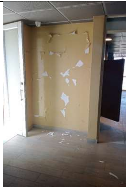
Filtraciones y daños en pintura en algunas áreas de las salas de velación.
