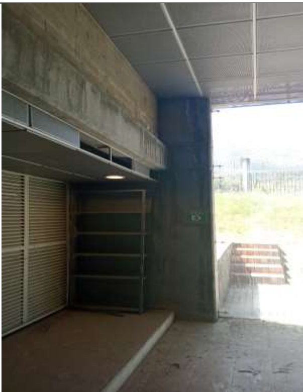
Filtraciones y daños en pintura en algunas áreas de las salas de velación.
