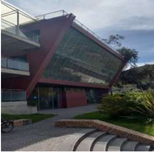
Fachada Salas de velación
