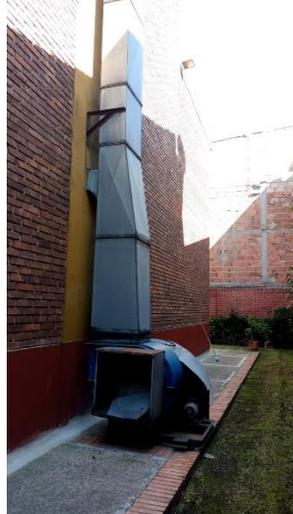
Ilustración 4422 Ducto Ciclo de Aire no funciona
