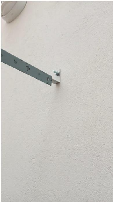
Ilustración 30 Estantería anclada en la parte superior
