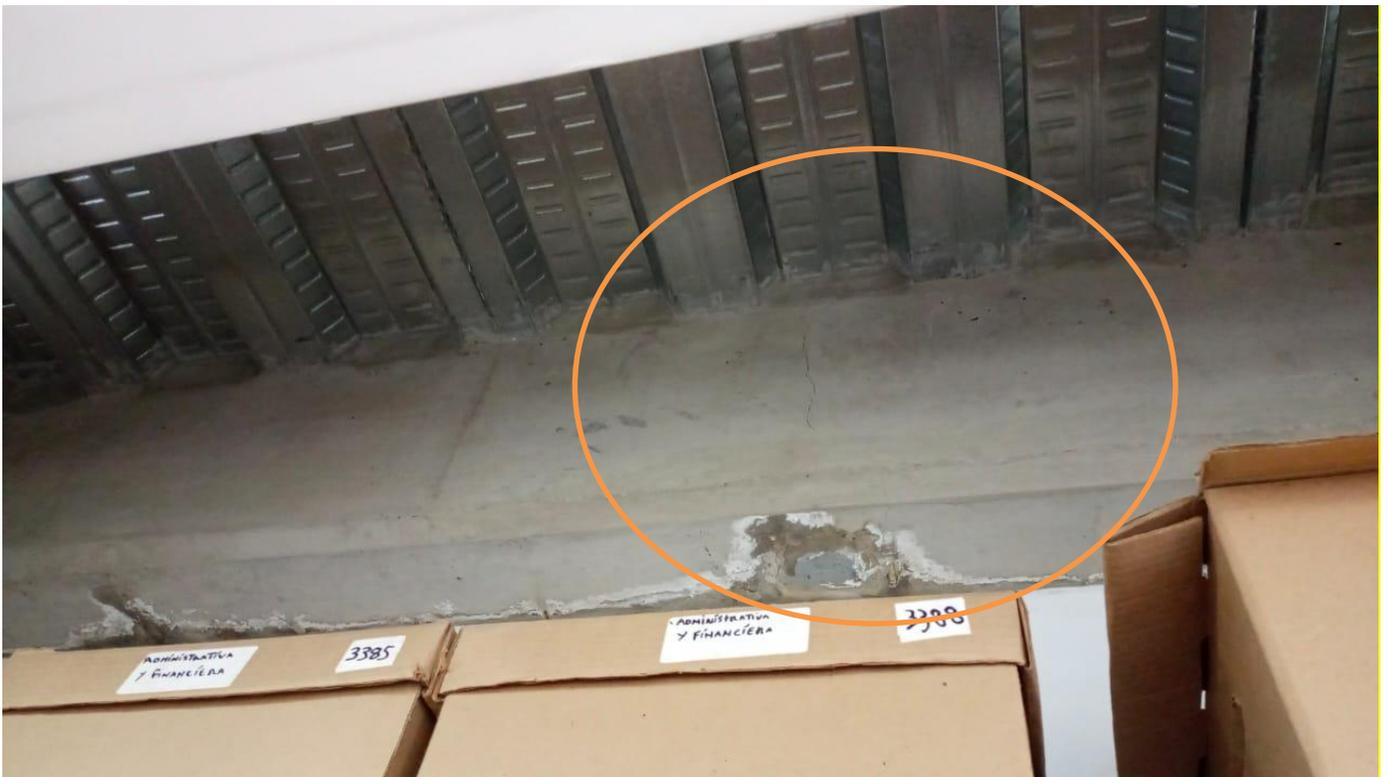
Ilustración 22 Gotera en depósito N° 1
