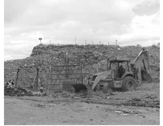
Operación en la zona, retrocargador y auxiliares en la zaranda.
