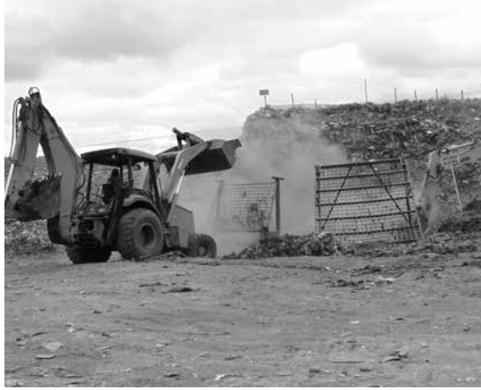
Tamizado de agregado reciclado y limpieza final de material.
