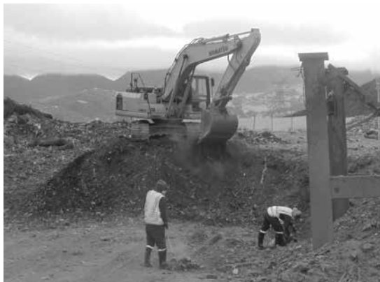
Tamizado de agregado reciclado, retroexcavadora en operación.
