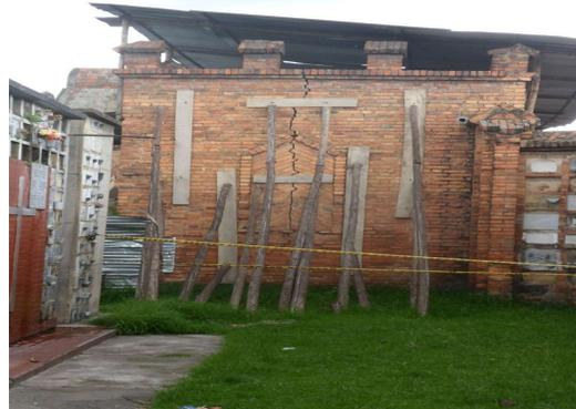
**RIESGO INMINENTE POR FACHADA COLAPSADA C SUR**
