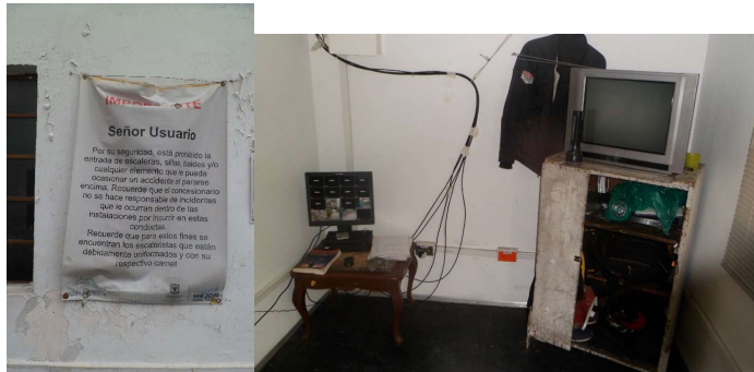
AVISOS EN MAL ESTADO C CENTRAL EVIDENCIA DE CAMARAS DE SEGURIDAD AVERIADAS CEMENTERIO SERAFÍN
