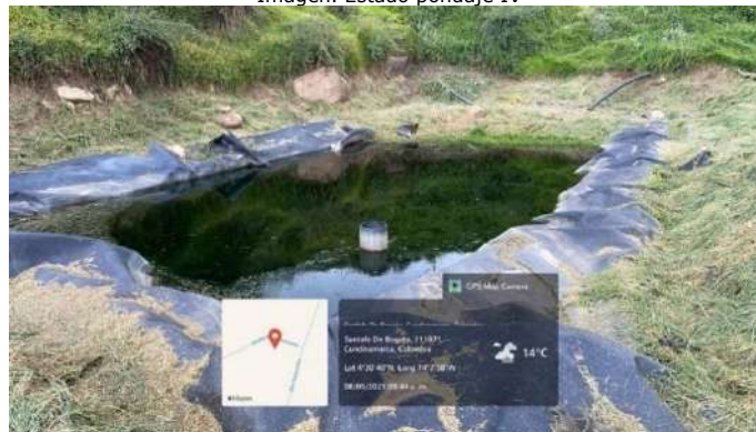
Imagen. Estado pondaje IV
