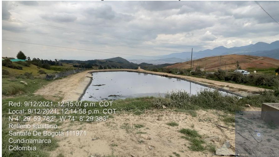
Imagen. Estado Actual de Pondaje VII
