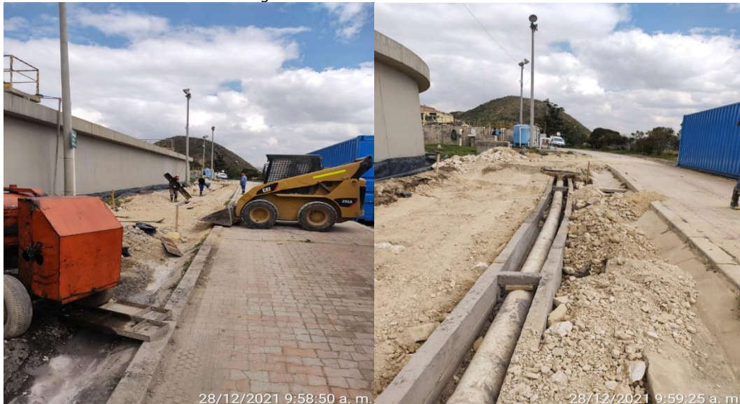
Imagen. Avances de Obras Civiles PTL
