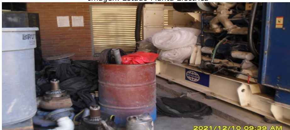
Imagen. Estado Planta Eléctrica
