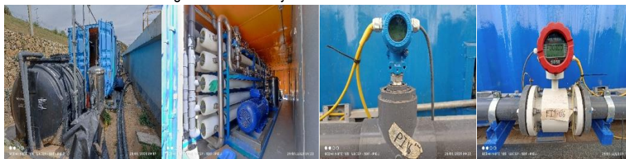
Imágenes. Obras Proyecto CGR denominado “Genesis”
