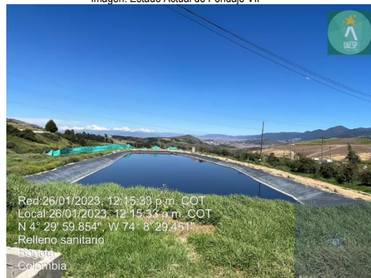
Imagen. Estado Actual de Pondaje VII
