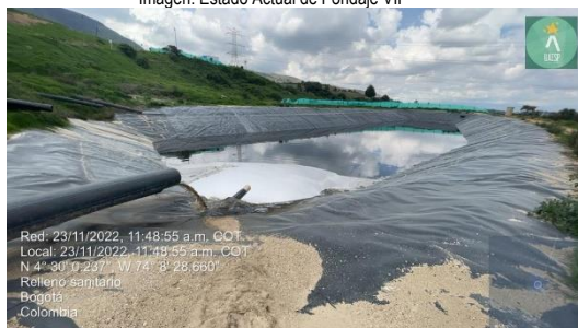
Imagen. Estado Actual de Pondaje VII
