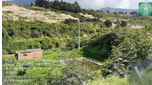
Imagen. Estado Actual de Pondajes PTL
