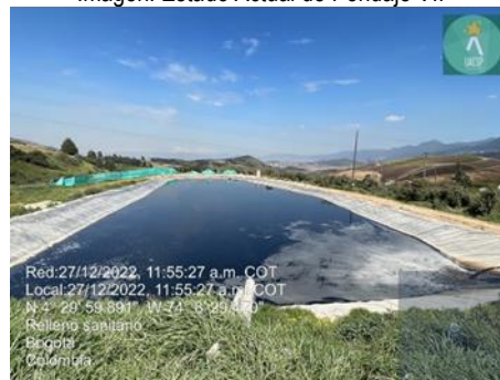
Imagen. Estado Actual de Pondaje VII
